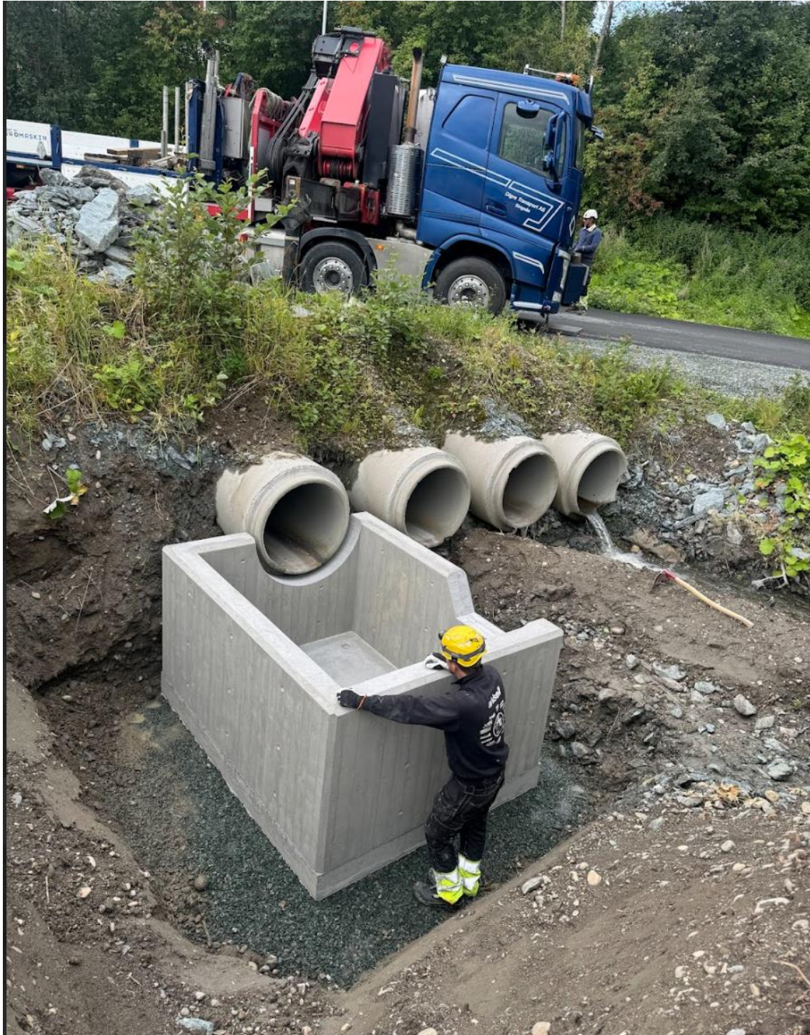
Figur 24: Det ble støpt en tilpasset betongkonstruksjon som ble montert under kommunal kulvert for å sikre oppvandring av fisk.
