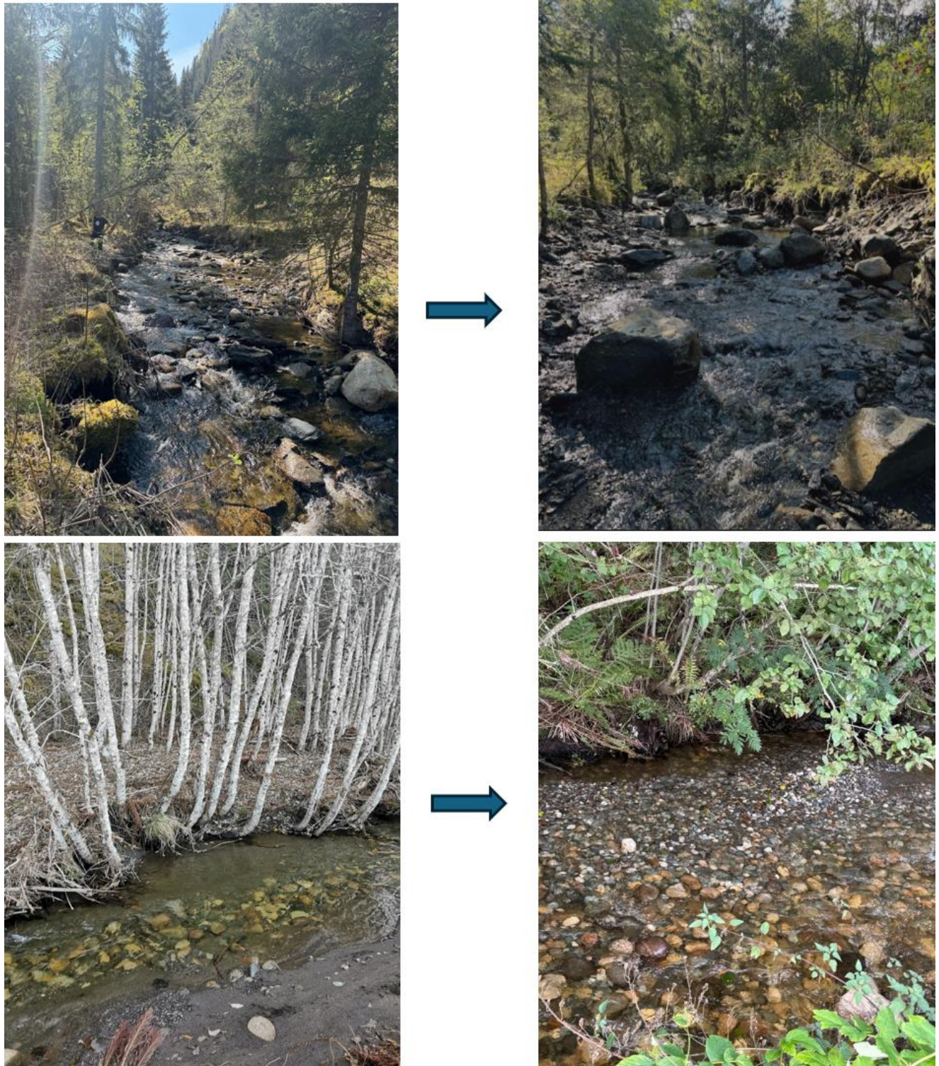
Figur 5: Før og etterbilder av tiltak. Utlegg av større stein og gytesubstrat. Finmasser ble fjernet fra bekkeløpet før utlegg av egnede masser.
