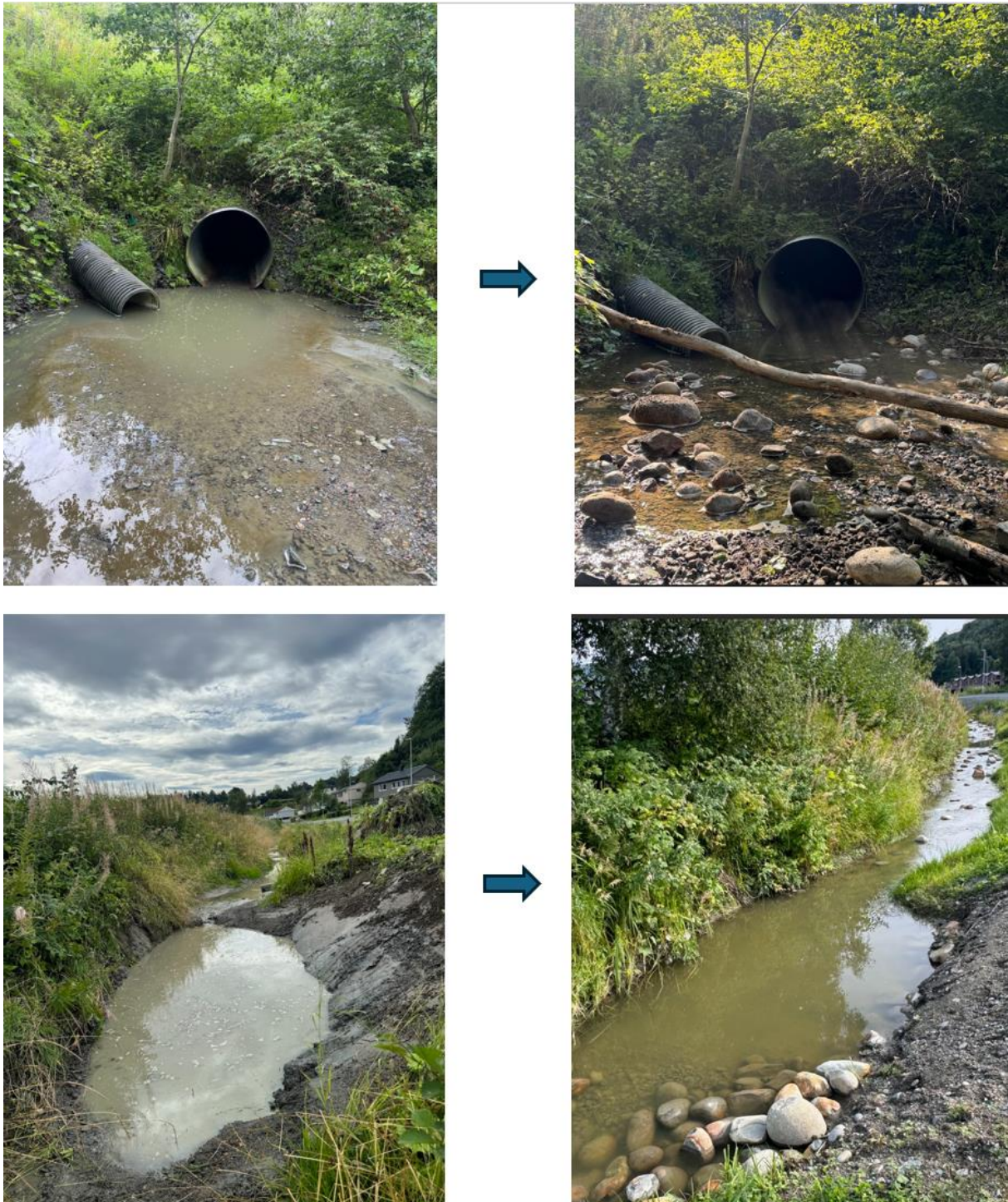
Figur 28: Før og etterbilder av tiltak i Varmbubekken. Det ble utgravd ni dypere kulper i bekken og lagt ut ca. 200 tonn med storstein og gytegrus.
