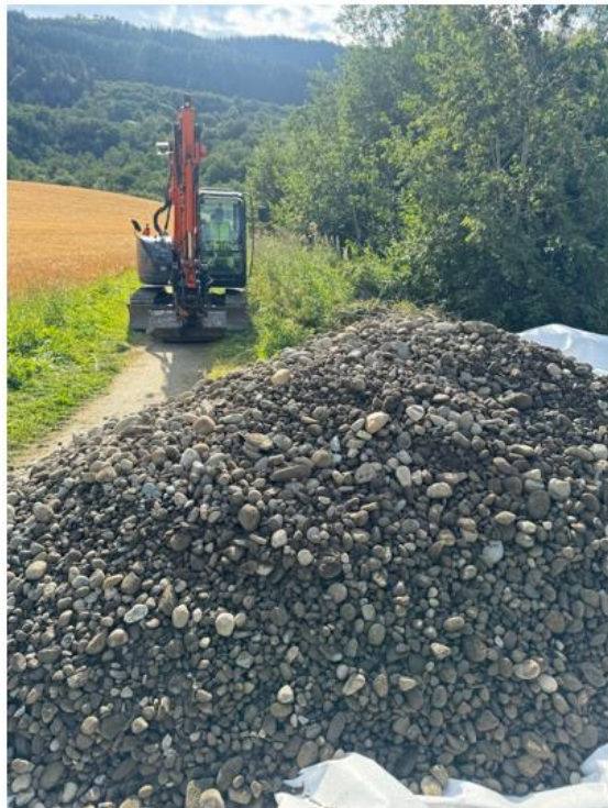
Figur 19: Bilder av utførelse av tiltak. Det ble tilkjørt flere hundre kubikk med gytegrus til loddbekken. Gravemaskin ble brukt for å grave kulper og utlegg av gytegrus.
