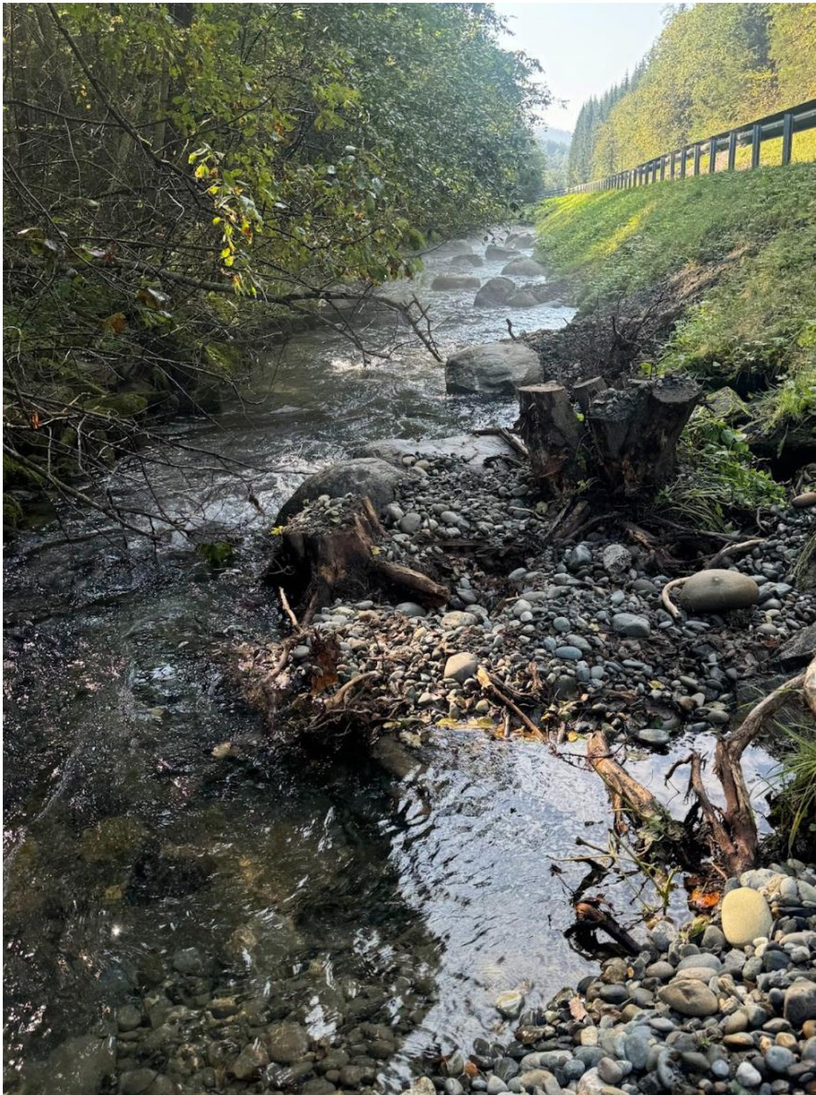
Figur 9: Utlegg av røtter, gytegrus og storstein. Røtter ble forankret med armeringsjern og stein. Skaper skjul og hvileområder for både ungfisk og gytefisk.
