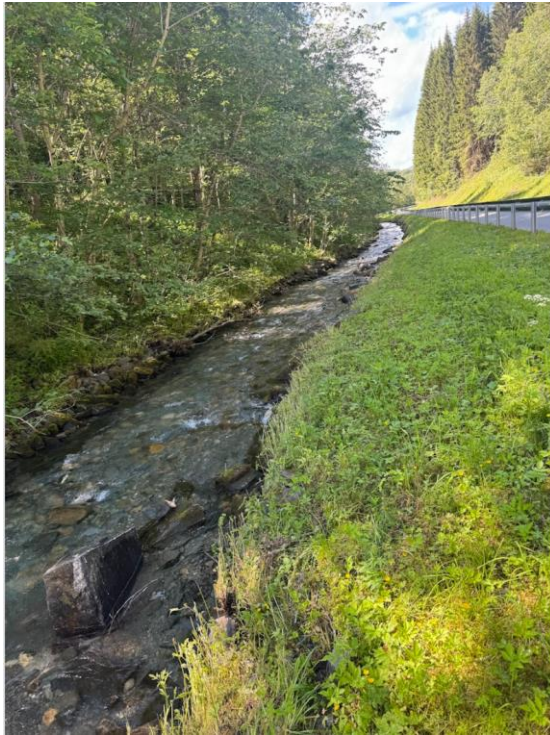
Figur 7: Før og etterbilder av tiltak. Mye storstein ble tilført og som skaper variasjon i vannhastighet og dybde.
