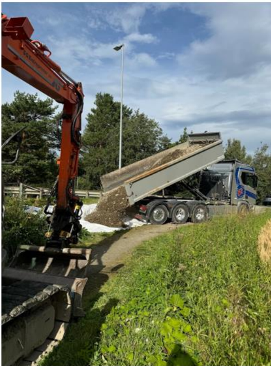
Figur 19: Bilder av utførelse av tiltak. Det ble tilkjørt flere hundre kubikk med gytegrus til loddbekken. Gravemaskin ble brukt for å grave kulper og utlegg av gytegrus.
