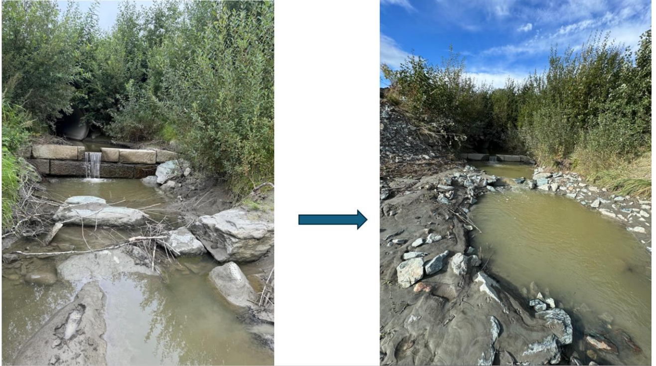
Figur 26: Bilder før og etter tiltak hvor Varmbubekken renner ut i Gaula. Før tiltak var spranget videre opp i bekken alt for høyt på lav til normal vannstand i Gaula. Tiltak med terskler av sprengstein hever vannspeilet og muliggjør fiskevandring selv på lav vannstand.
