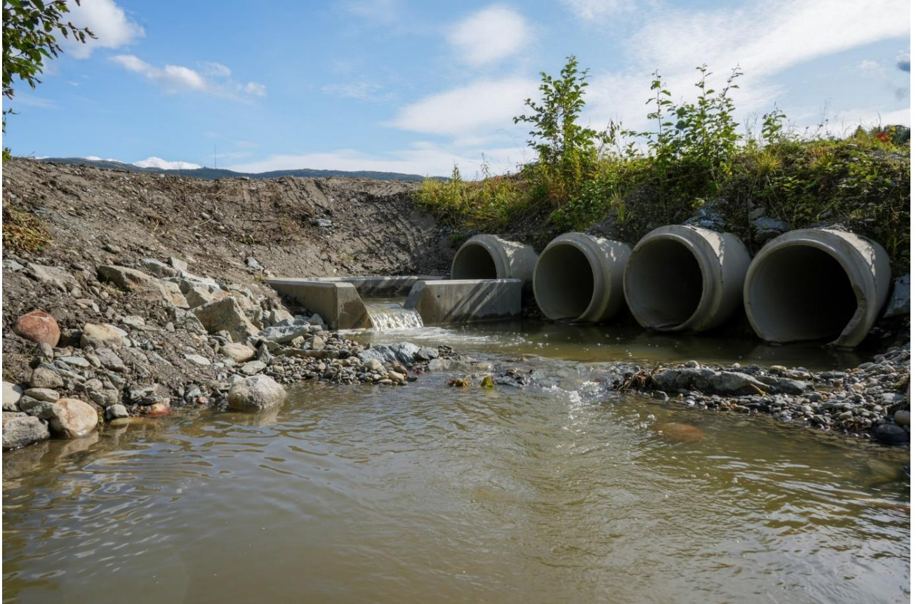
Figur 25: Kommunal kulvert etter ferdig tiltak. Vannspeil er hevet med sprengsteinterskeler inn mot betongkonstruksjon for å danne sprangkulp for fisk. Høydeforskjell mellom satskulp og betongkontruksjon er ca. 10 cm, og skal muliggjøre vandring for både ungfisk og voksen sjørørret.
