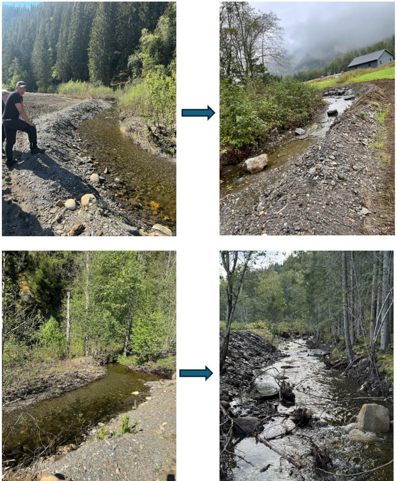
Figur 4: Før og etterbilder av tiltak. Kantvegetasjon skal få revegeteres naturlig for stabilisering av elvekant.
